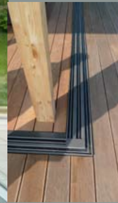
Barrierefreier Bodenbereich – keine störende Schwelle
