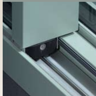
Ein Abstreifer reinigt die Edelstahl-Rundschiene bei jedem Schiebevorgang
